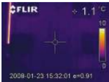
10. Termogramma a impianto riscaldamento spento: il colore del termogramma è omogeneo e freddo (blu).
