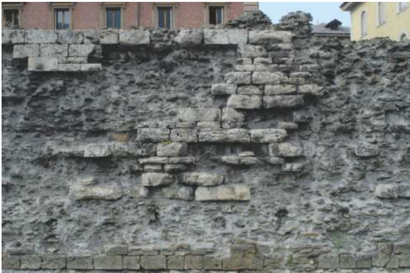
2. Esempio di conservazione dell'antico paramento esterno delle mura. (P. Salonia)
