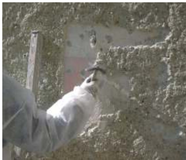
2. Esterno della Chapelle des blancs. L'indagine stratigrafica evidenzia tracce di decorazioni non superficiali. (M. Lévêque)
