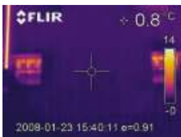
11. Termogramma all'accensione dell'impianto: il calore esce dalle bocchette.
